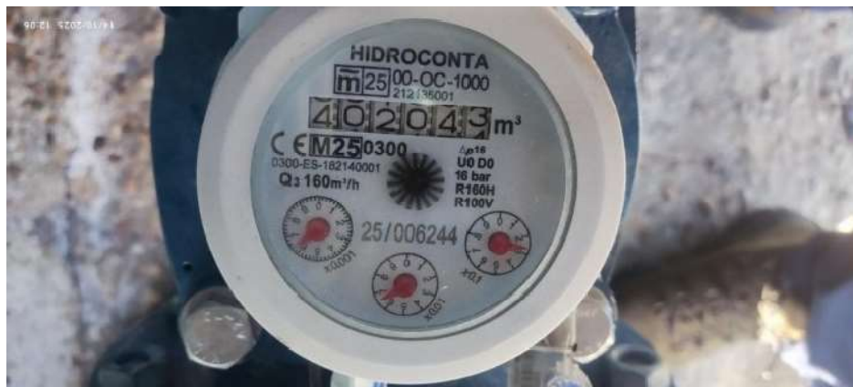
Ilustración 10. Captación n.º 1. Contador CARD.
