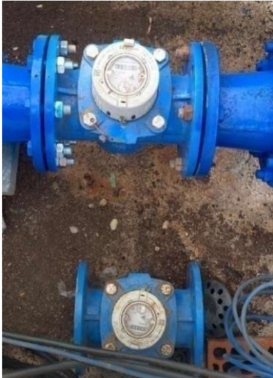
Fotografía 15 – Detalle de Contadores CHT (uno montado y funcionando) y otro desmontado en Pozo Nº1.
