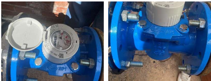
Fotografías 5 y 6. – Detalle del estado de bridas y tornillería del contador de CHT
