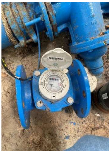
Fotografías 28 y 29 – Detalles del contador de CHT (desmontado) en el suelo del Pozo N°2
