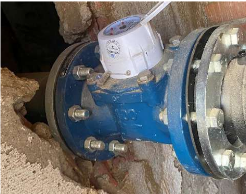
Fotografías 36 y 37 – Detalle de los contadores CARD y CHT del Pozo Nº5 (primero y segundo en la línea s/ sentido del agua, respectivamente)
