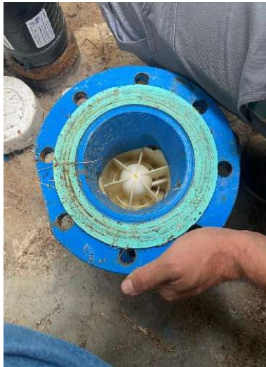
Fotografías 28 y 29 – Detalles del contador de CHT (desmontado) en el suelo del Pozo N°2
