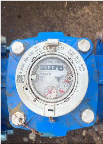
Fotografías 16 y 17 – Detalle de Contadores CHT (Funcional y desmontado) del Pozo Nº1.
