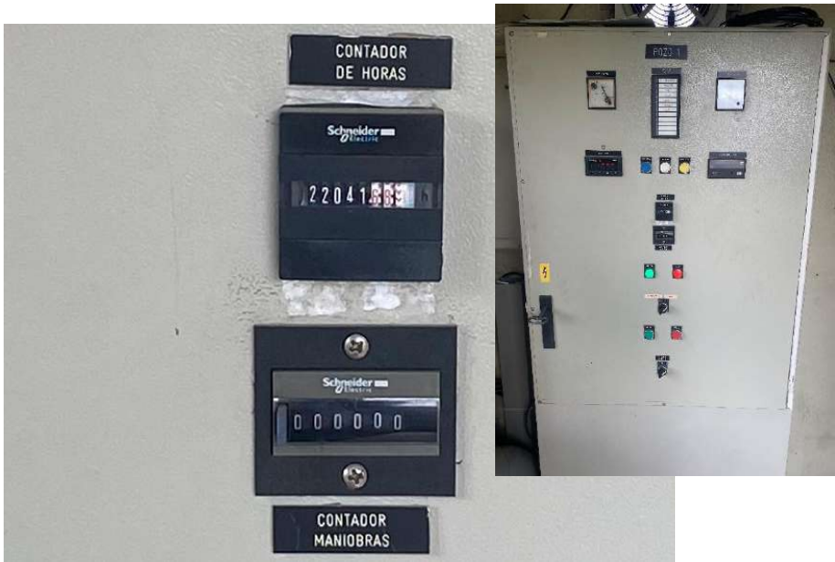
Fotografía 24 – Cuadro eléctrico del Pozo N°1 y Zoom de los contadores de horas y maniobras
