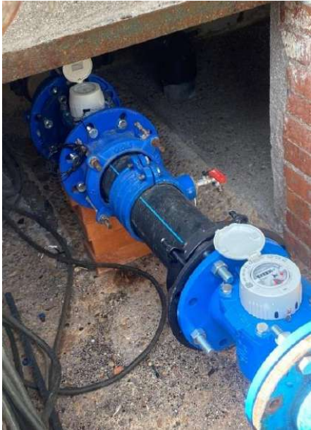
Fotografía 1. – Detalle de la disposición de contadores en tubería de Pozo Nº11
