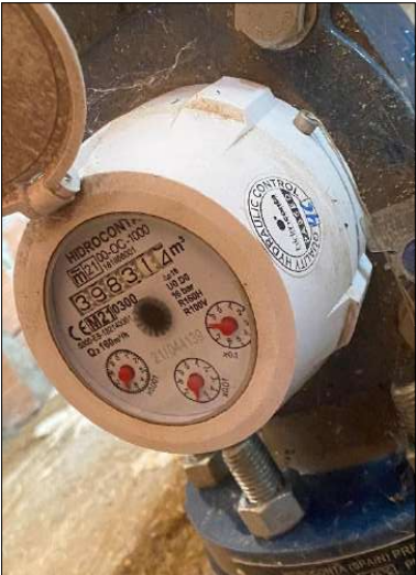
Fotografías 38 y 39 – Detalle del contador CARD del Pozo Nº5 (primero en la línea s/ sentido del agua)
