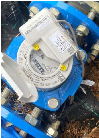
Fotografías 36 y 37 – Detalle de los contadores CARD y CHT del Pozo Nº5 (primero y segundo en la línea s/ sentido del agua, respectivamente)
